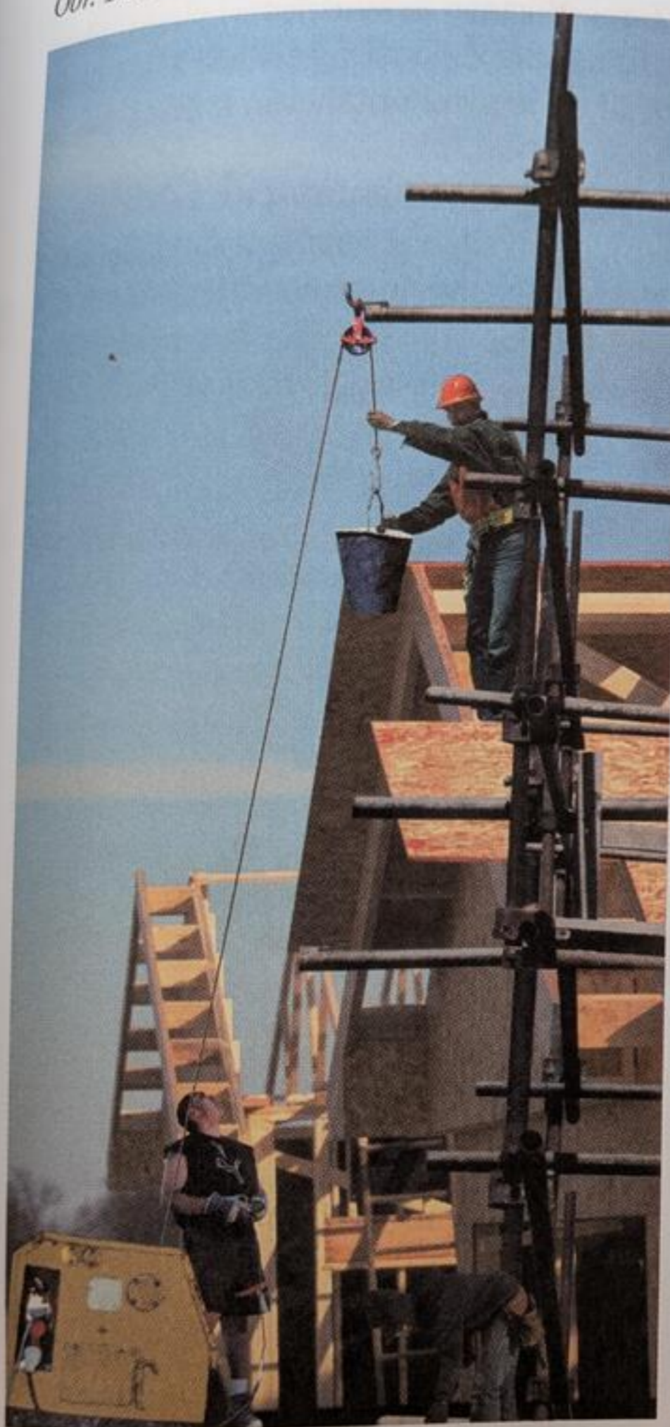
Obr. 1.95 Užití pevné kladky
